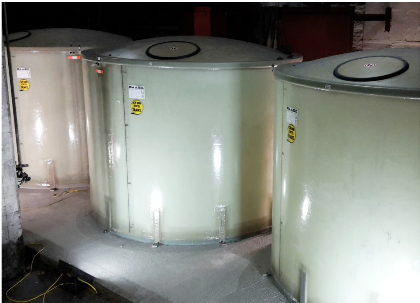
Die Flachbodentanks des Typs SV 30-144 C3/D haben jeweils ein Nutzvolumen von 14.400 Litern.
