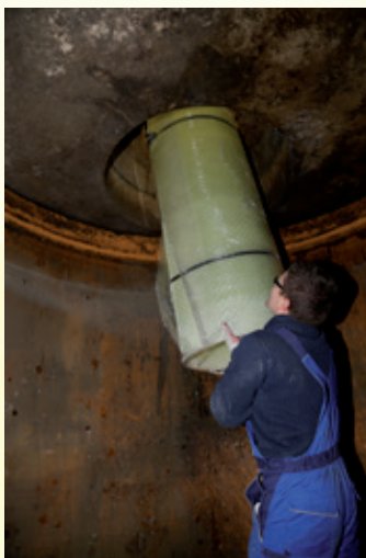
Sanierungsbedürftige Abscheider aus Beton können mit Platten aus Glasfaserverstärktem Kunststoff dauerhaft und preisgünstig ausgekleidet werden
